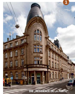
DIE „RÉSIDENCE DE LA POSTE“
