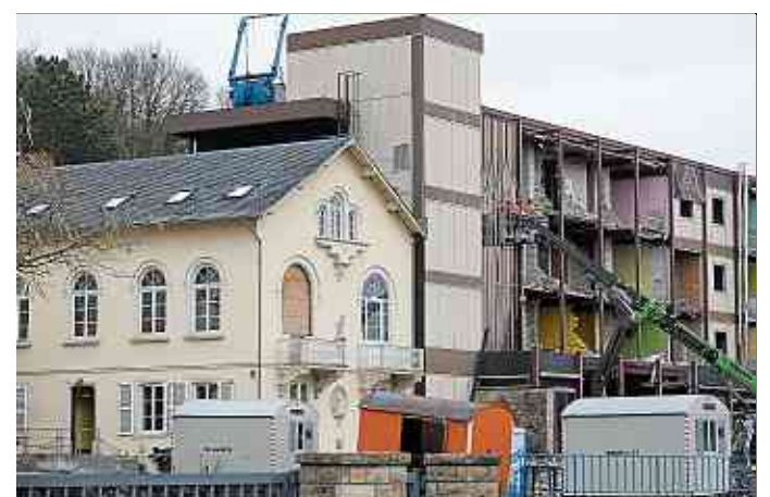
Die Kapelle (links) wird vom Abriss verschont. (Foto: Fern Morbach)
